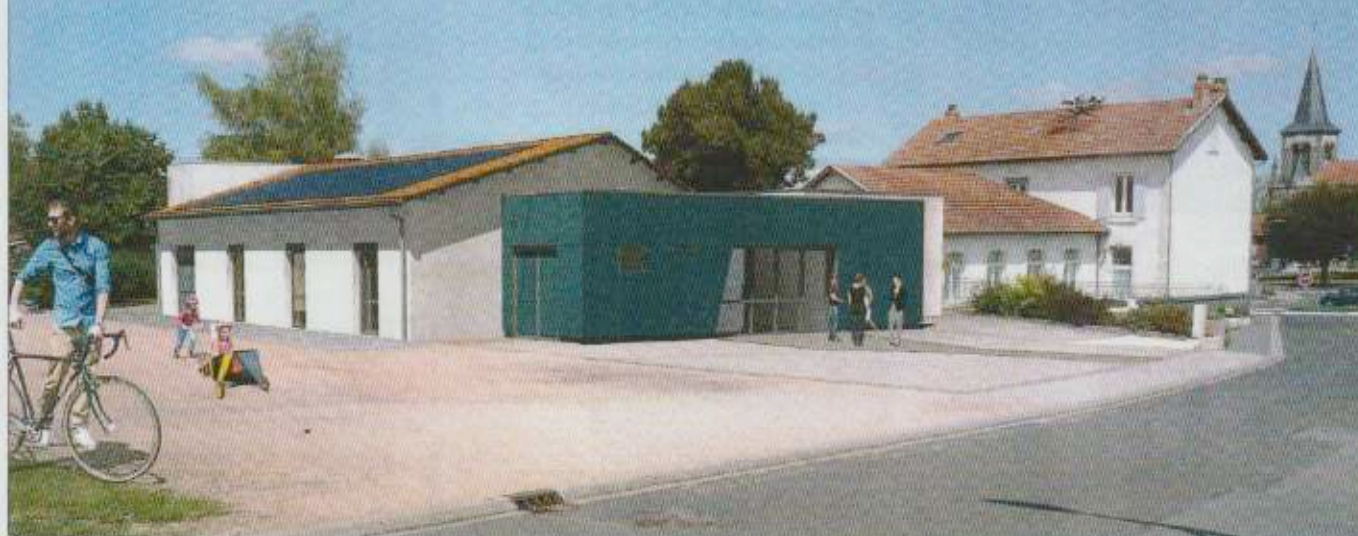
Vue d'ensemble du projet initial - APRES
