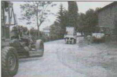
Rue des Douves : Entreprise GUITTARD : décaissage, apport de marchandises, bordures de trottoir, entrées en enrobé, patte d'oie (route de Surat) en
