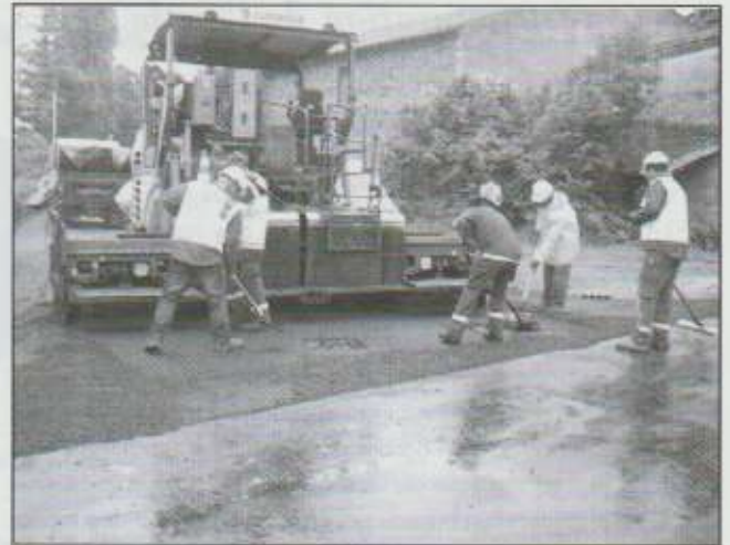
Rue des Paquiers : Entreprise GUITTARD : décaissage, bordures de trottoir du côté des maisons, branchem- ent/reprise, enrobé, pour un montant de 25 767,50 € HT
